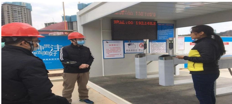
局领导检查施工项目疫情防控工作落实情况
