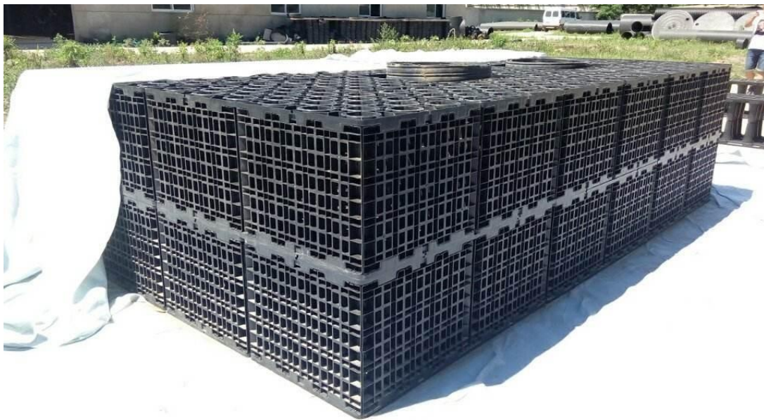
图15 雨水罐、雨水湿塘、雨水调蓄模块实景图
