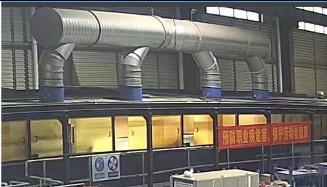
图 4-2 废气收集示意图
