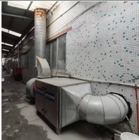
DA001 (水喷淋 (喷淋塔位于车间室内)+活性炭吸附)
