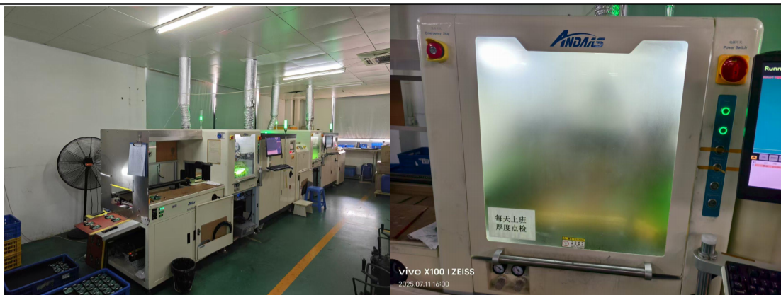
图 4-1 涂覆工序废气收集系统
