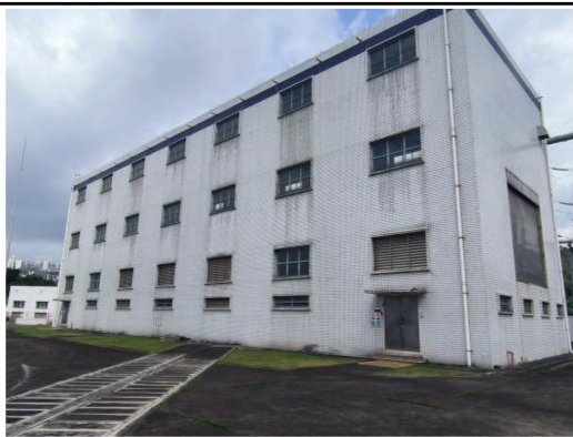
220kV 配电装置楼
