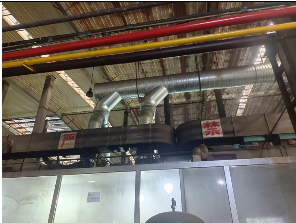
图 3 现有喷漆收集设施图
