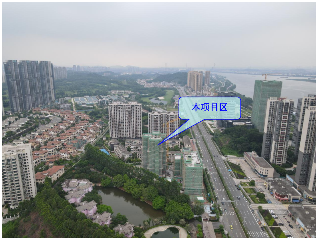
照片2 项目区建筑物施工现状
