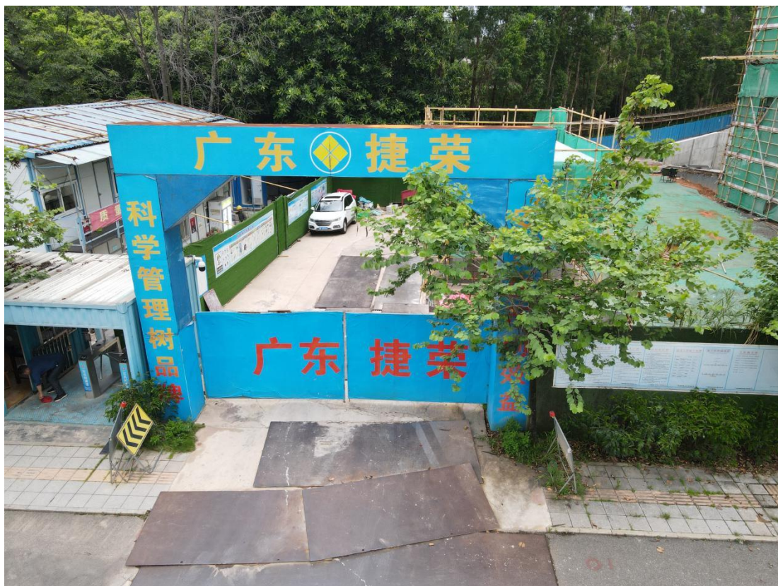
照片3 项目施工出入口
