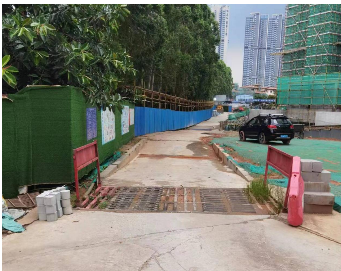
照片4 项目施工出入口洗车池
